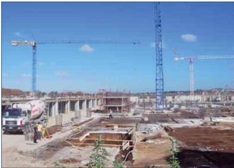
In alto a sinistra il progetto del Policlinico dei Castelli e nelle altre due foto il cantiere
