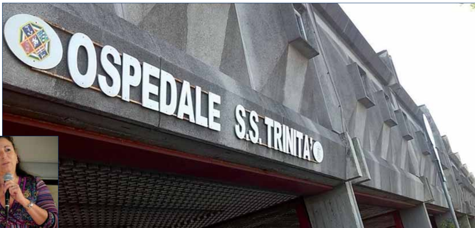
A sinistra il direttore generale dell'Asl di Frosinone, Isabella Mastrobuono; sopra l'ospedale di Sora
